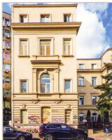
Corp lateral stânga
